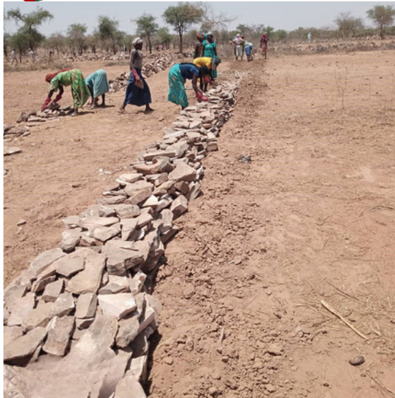
Barrière contre la Désertification : Érigés collectivement, ces cordons pierreux sont une infrastructure essentielle dans la lutte contre l'érosion des sols et la désertification. Ce travail soutient la résilience agricole et assure la préservation des terres pour l'avenir des communautés.
